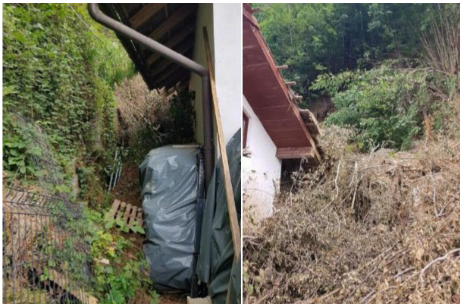
Slika 4.3: Podporni zid nad stanovanjskim objektom 12a (levo) in splazeli material med stanovanjsko hišo Stahovica 12a in 13
