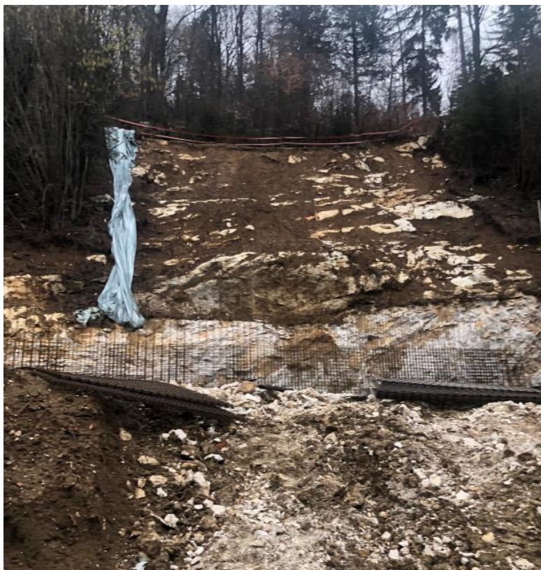
Slika 4.4: Podporni zid nad stanovanjskim objektom 12a (levo) in splazeli material med stanovanjsko hišo Stahovica 12a in 13
