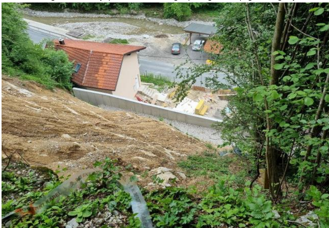
Slika 4.6: Pogled na območje plazu in že saniranega opornega zidu – pogled od zgoraj navzdol
