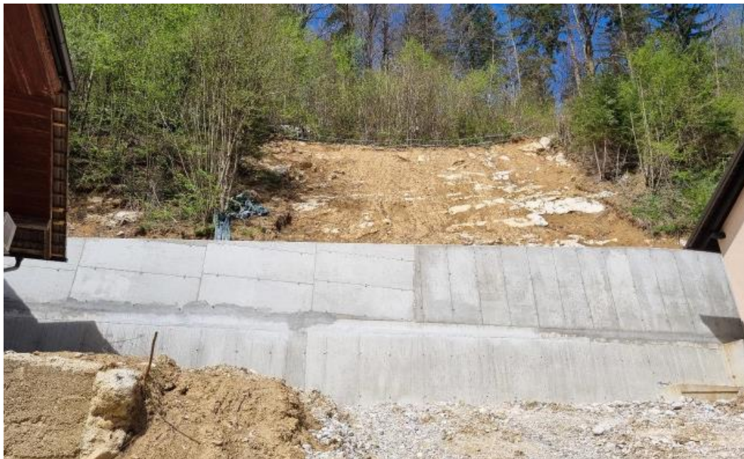
Slika 4.5: Pogled na območje plazu in že saniranega opornega zidu – pogled od spodaj navzgor
