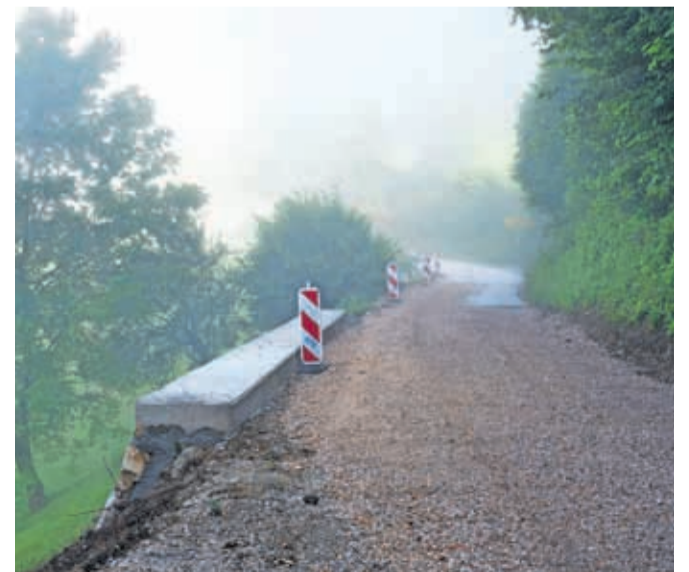
Eden izmed desetih odsekov, ki se sanirajo na cesti med Kamnikom in Veliko Lašno. / FOTO: ŠPELA ŠIMENC
