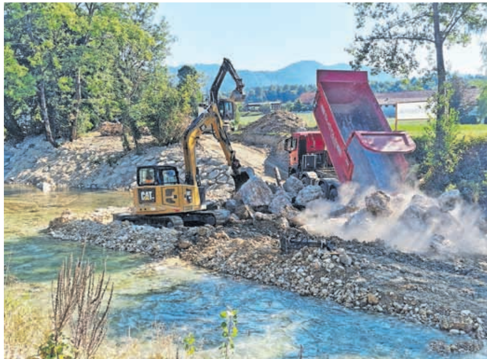
Prejšnji teden se je zaključila gradnja protipoplavnega nasipa Šmarca–Nožice. / FOTO: OBČINA KAMNIK
